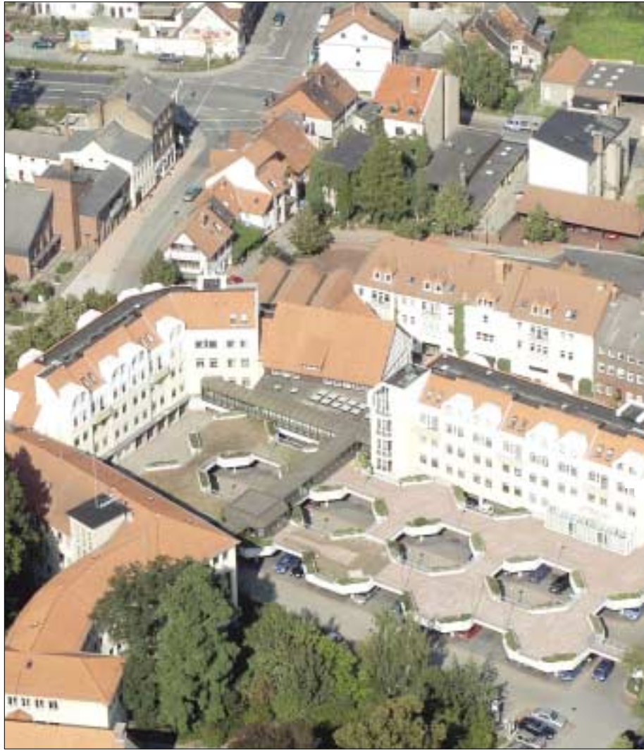
Das Ringen um die Macht im Kreishaus hat bereits begonnen.
